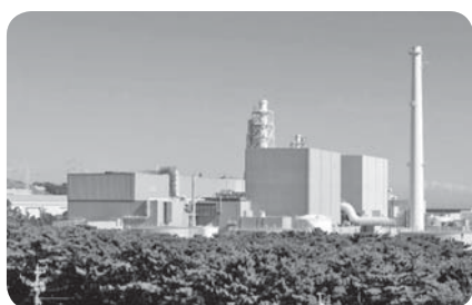
浜岡原子力発電所
